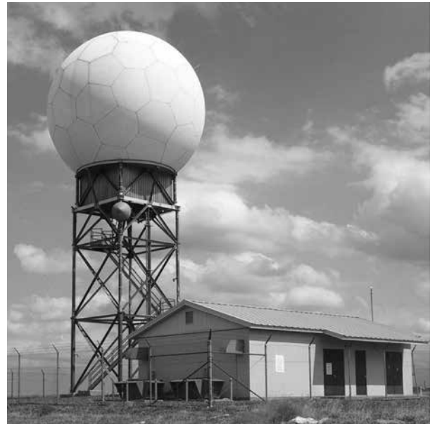
圖 4、高解析多普勒雷達，能識別微爆氣流、陣風鋒 (Gust Front) 等現象
